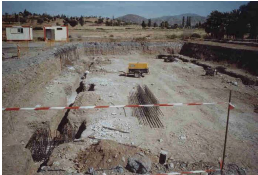
21 Vista general de la excavación
