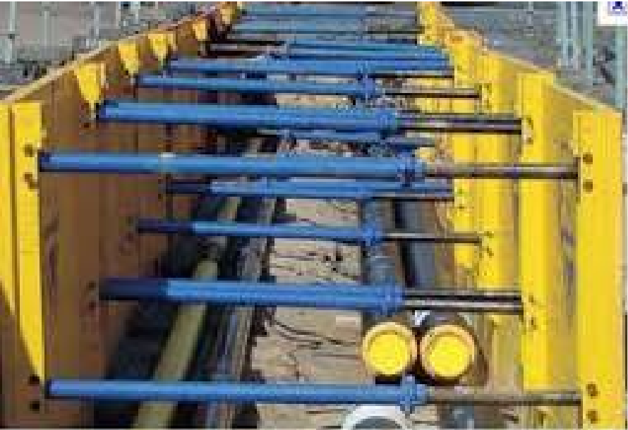
30 Entibación simple en zapata
