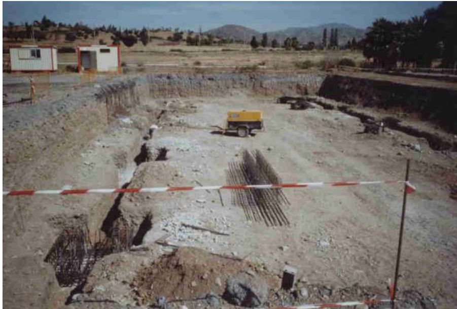
Vista general de la excavación
