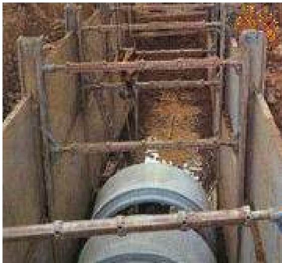
Entibación de zanja de saneamiento
